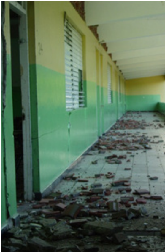
COLAPSOS DE BLOQUES CALADOS EN PASILLOS Y ESCALERAS, ESCUELA VIRGINIA ORTEA, SISMO DE PUERTO PLATA 2003
