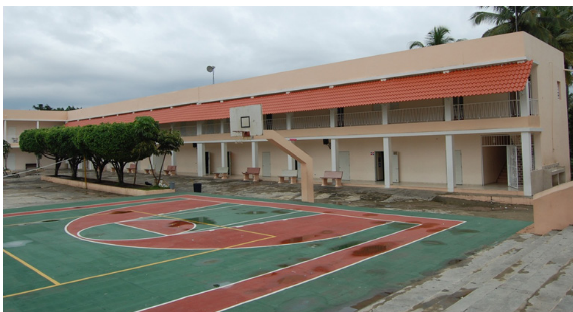
VISTA DE LA EDIFICACIÓN ESCOLAR DESPUÉS DE SER REFORZADA
