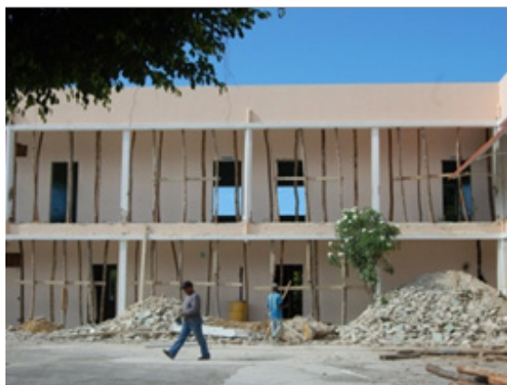
EN PROCESO DE REFUERZO (RETROFIT)
