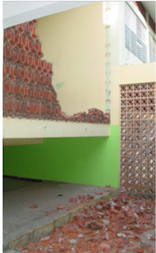
COLAPSOS DE BLOQUES CALADOS EN PASILLOS Y ESCALERAS, ESCUELA VIRGINIA ORTEA, SISMO DE PUERTO PLATA 2003
