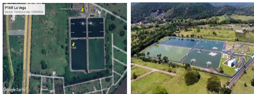
Planta de Tratamiento de Agua Residuales. Pontón, La Vega
