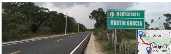
Fuente: MOPC - Tramo Sabaneta - Martín García
